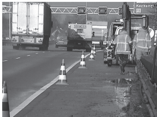
Figuur 1 Wegwerkzaamheden langs de snelweg
