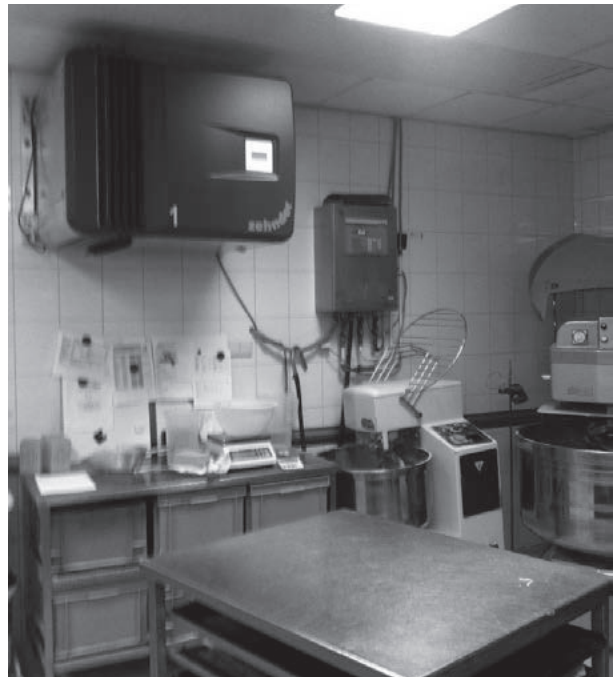
Figuur 4 Afzuigunit (zwarte kast) boven de werktafel
