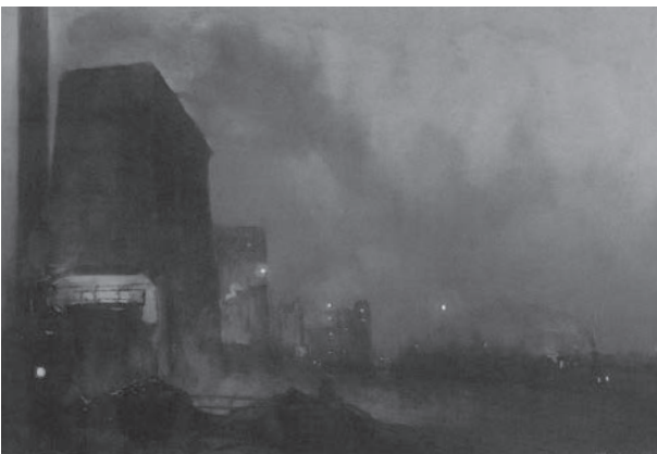
Het blussen van de hete cokes in de blustorens van de Staatsmijn Emma
