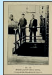
Veiligheidstechniek in de praktijk. Op de afbeelding staat een voorbeeld van verbetering van de veiligheid door een trapgat van een reling te voorzien. Het oorspronkelijke bijschrift luidt: "Goed beveiligd trapgat. Met dank aan Goulds Manufacturing Company". Uit: Practical Safety Methods and Devices, Manufacturing and Engineering , geschreven door Cowee. Library of Congress (HD7273 .C6)
