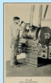
Veiligheidstechniek in de praktijk. Op de afbeelding staat een voorbeeld van een veiligheidsriem-schakelaar om te voorkomen dat de aandrijfriem in machines met de hand moet worden geschaafd. Met dank aan R.K. Le Blond Machine Tool Co. Uit: Practical Safety Methods and Devices, Manufacturing and Engineering , geschreven door Cowee. Library of Congress (HD7273 .C6)
